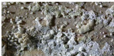
土質類古物釉料龜裂與剝離
